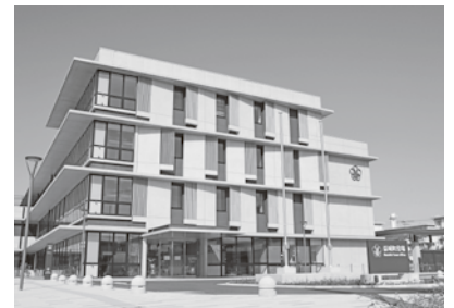
熊本地震からの復興のシンボルとなる役場新庁舎が令和5年3月に完成しました。安心安全な拠点として、災害時にインフラが供給停止しても、3日間は機能維持ができる設備が整っています。
