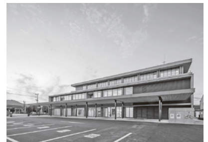
平成 28 年熊本地震で大きく損壊し、建て替えられた宇土市役所新庁舎。庁舎の一角には地震の記憶を伝える「震災ミュージアム」が設けられ、被災当時の市内の様子を写した写真などが展示されています。
