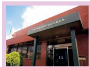
天草支所管轄
